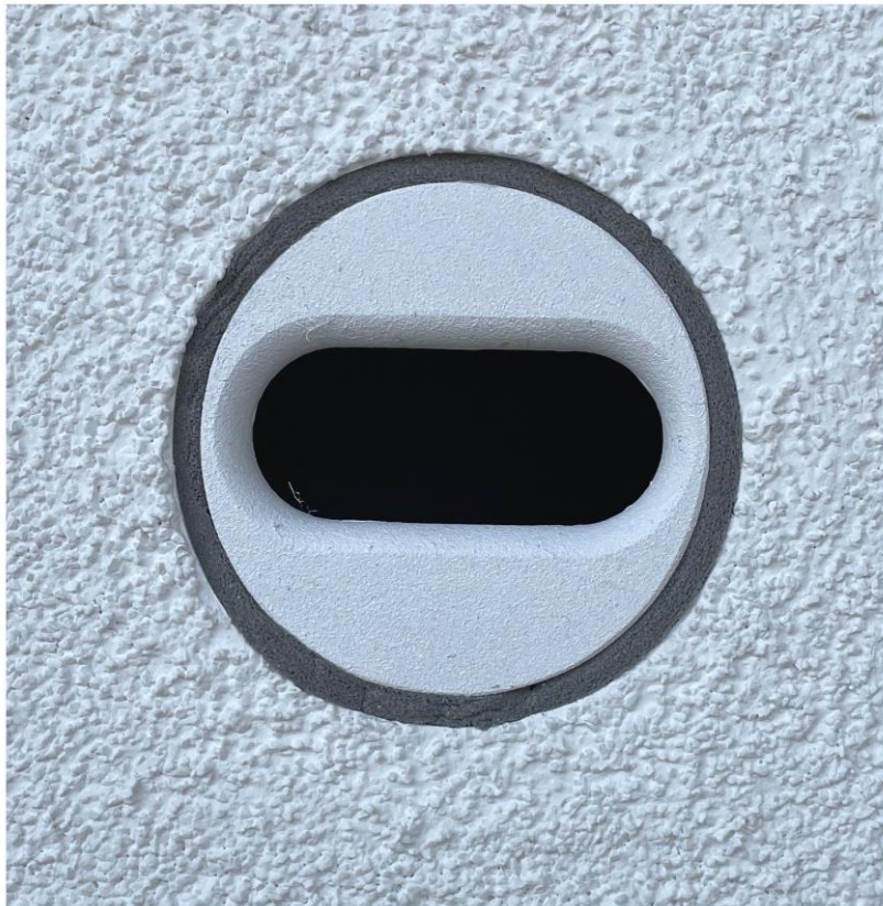
slika: StoElement Fauna MS-I 11 rozeta z obodnim tesnilnim trakom za fuge (StoReno Fugendichtband 10/4)
