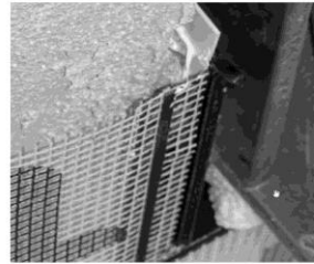
Eingebautes Eckstück mit Fugenflankenprofil-Verbinder
