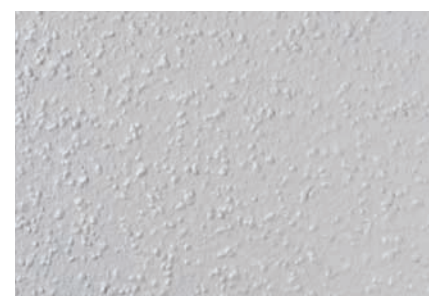
Schlussbeschichtung optional z.B.: StoSil Decor Fine oder Medium
