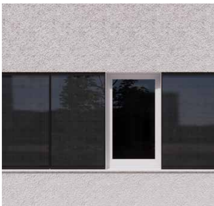
Mešana fasada z ometom: StoSignature Rough 10
