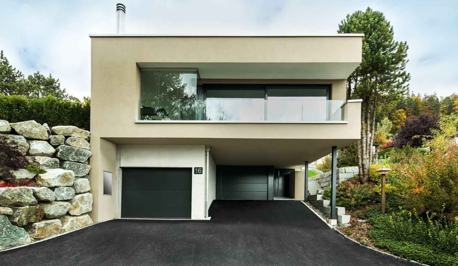
Hiša Brenner, Oberuzwil, CH
